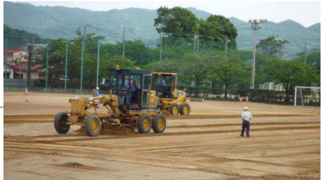
Rimozione di strati superficiali di suolo
