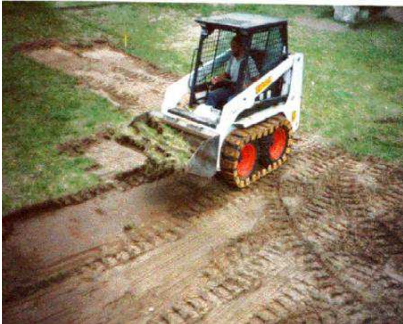
Rimozione di strati superficiali di suolo
